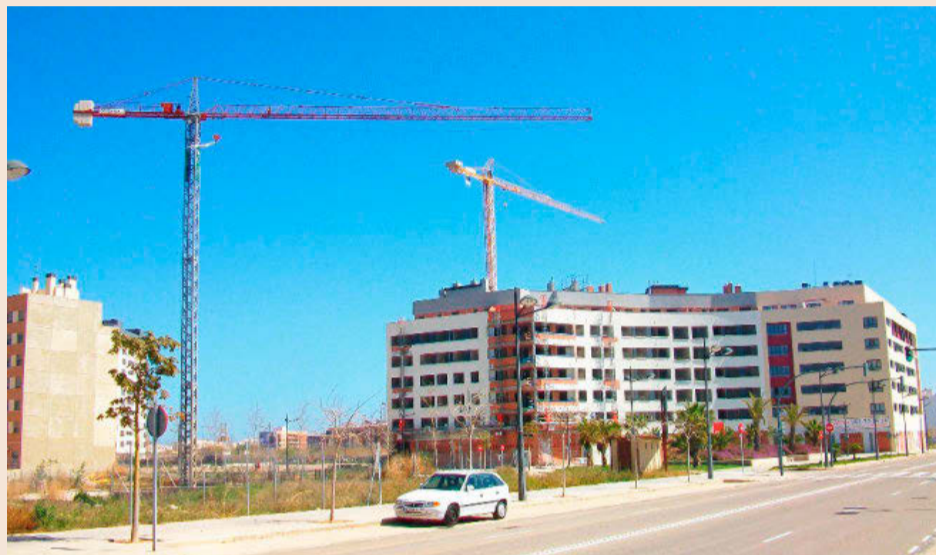
Obras de edificación de viviendas en Valencia.
